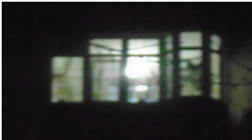
Vedere Balcon, imediat după poza precedentă.
